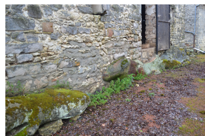
Les fondations posées à même la platière
