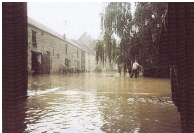
Inondation de la ferme en 2005
