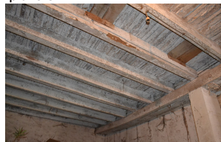
Au-dessus de l'écurie le plancher destiné à recevoir le fourrage
